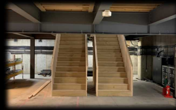
舞台下も工事して展示スペースに転換
